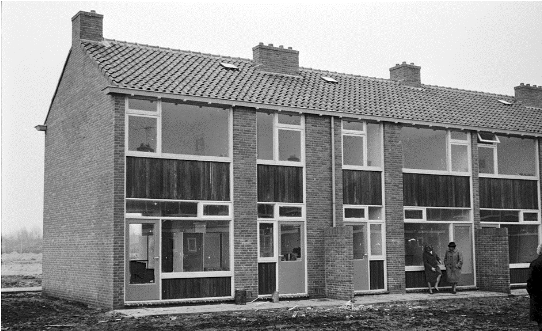
Achterzijde van de Coba Ritsemastraat in aanbouw. Ongeveer 1965.
