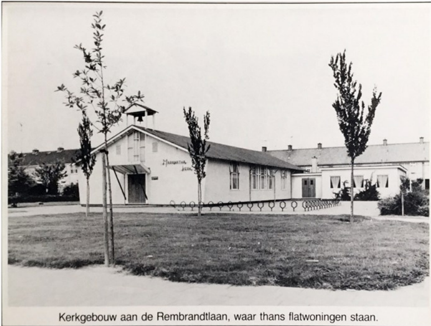
Houten noodkerk (Maranathakerk) op de hoek van de Rembrandtlaan en de Frans Halsstraat. De kerk is in 1966 in gebruik genomen en in 1981 verhuisd naar de Molenvlietlaan 10.
