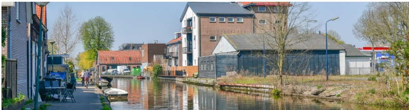
Locatie Rembrandtbrug gezien vanaf fietspad Barwoutswaarder.
