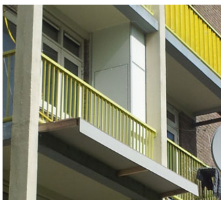
Figuur 4. CV-kast op het balkon (bron: Renoparts)
